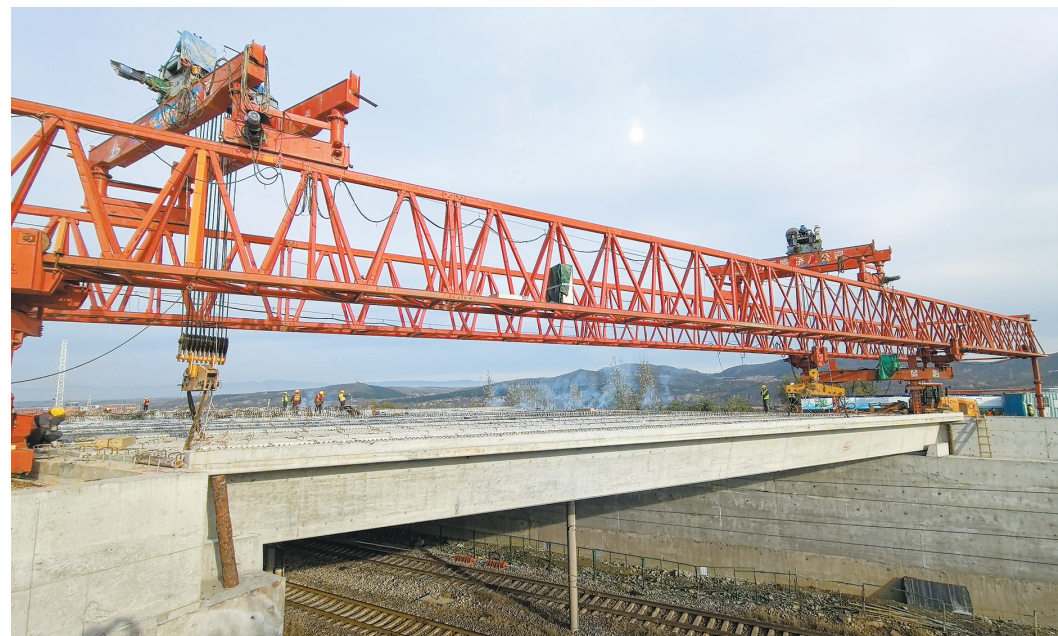
10月20日上午9时,在大同公路分局承建晋通国道燕子山立交桥梁改造项目施工现场,JQ200—40A3架桥机将最后一根箱梁顺利安装在桥台支座上,至此,全桥共计26片梁板顺利吊装完成,为实现年内通车目标奠定了坚实基础。位于大同市境内晋煤外送大通道——国道109线上的燕子山立交桥上跨铁路云冈支线和铁丰线,桥长90.7米,为沥青混凝土路面。柴立峰摄
