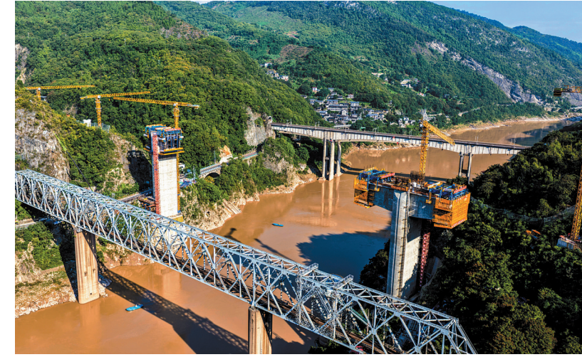
10月28日,随着新一代智慧悬臂造桥机的成功架设,由中铁十一局承建的西渝高铁嘉陵江特大桥进入桥面施工阶段,这也是智慧悬臂造桥机在西南地区斜拉索桥施工中首次成功应用,改变了传统挂篮依赖人工的作业模式。这是10月28日拍摄的西渝高铁嘉陵江特大桥建设现场(无人拍照)。新华社记者 唐奕摄
