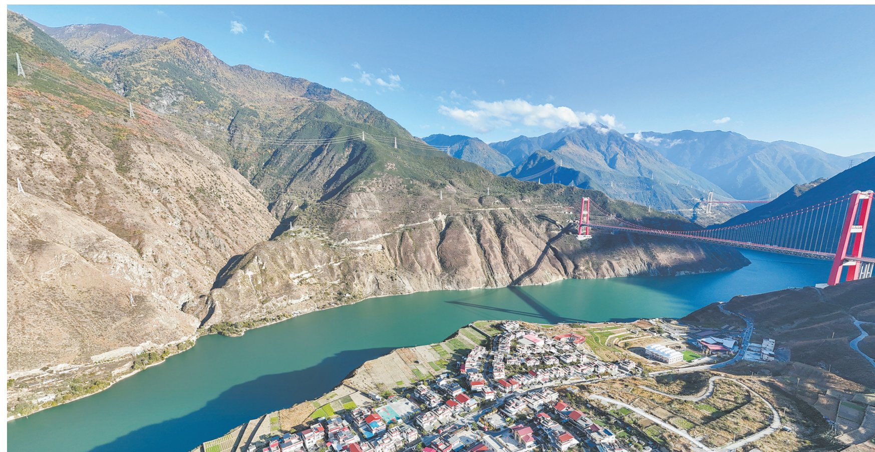
这是11月6日在四川省泸定县泸定水电站库区拍摄的“引大济岷”工程取水口大致方位(无人机照片)。
