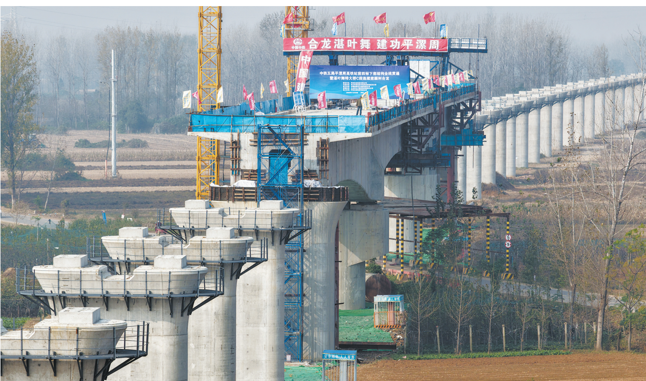
11月13日拍摄的合龙后的平深周高铁叶舞特大桥C段连续梁（无人机照片）。11月13日凌晨，由中铁五局承建的平（顶山）深（河川）口高铁叶舞特大桥C段连续梁顺利合龙，标志着该标段桥梁下部结构无断点全部贯通。据了解，平深周高铁是完善中原地区高铁网络的重要工程，设计时速350公里。 新华社记者 李嘉南摄
