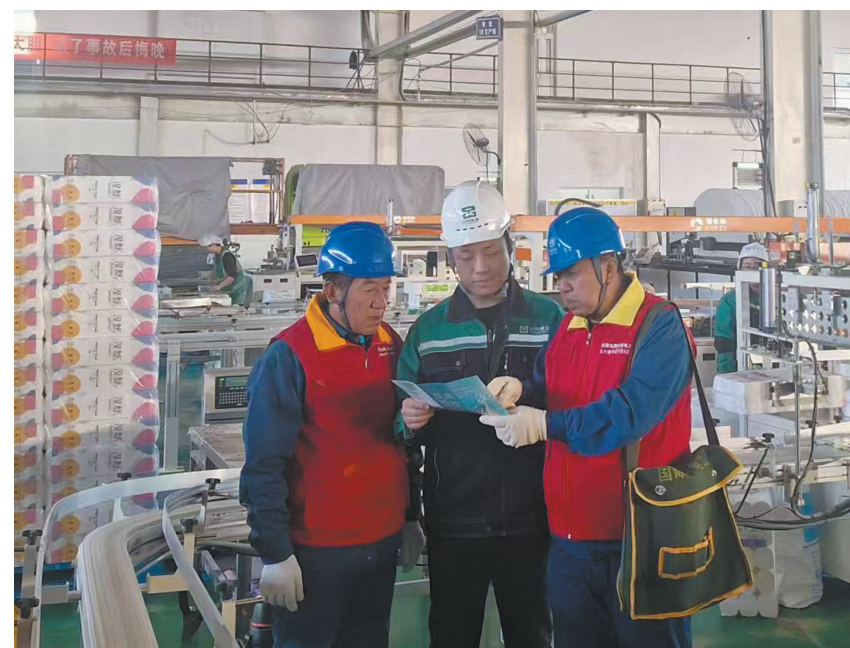
立冬过后,为进一步提升辖区居民、企业冬季安全用电意识,国网大同市云州区供电公司工作人员积极开展用电检查和用电安全宣传。图为11月19日,国网大同市云州区供电公司组织共产党员服务队和青年突击队来到山西云网织业有限公司,协助用户对高低压配电箱、变压器等设施进行检查,并开展安全用电宣传。本报记者 于宏 通讯员 王文正 摄
