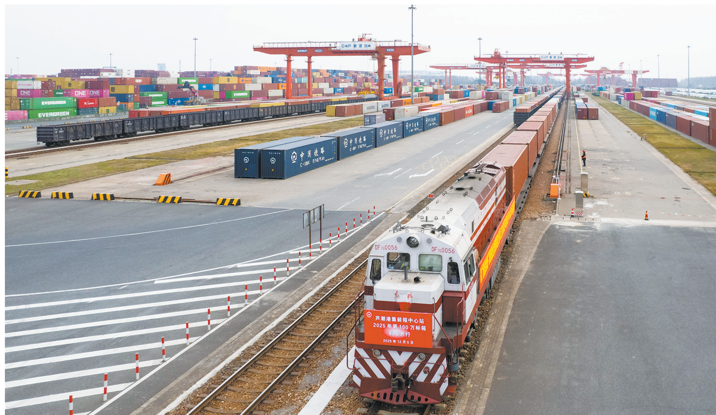
上海海铁联运业务量突破一百万标箱 十二月五日拍摄的上海铁路港集装箱中心站“无人照相机”照片。十二月五日,越轨有太阳能光伏组件、汽车零部件等货物的海铁联运量突破一百万标箱,同比增长近两成,创历史新高。 新华社记者 王翔摄
