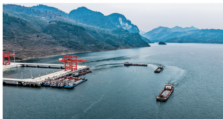
12月16日,货船从瓮安港云中港区启运出发(无人机照片)。12月16日,随着汽笛长鸣,桥式起重机将装有沉淀硫酸钡的集装箱吊入货船准备启运,贵州省首个自动化港口——瓮安港云中港区正式开港。瓮安港云中港区建设有2个500吨级兼1000吨级集装箱专用泊位及相应的配套设施,设计年吞吐量120万吨,是贵州省首个专业化、智能化、现代化的港口。云中港区投运后可充分发挥水运运能大、成本低、绿色低碳等比较优势,降低综合物流成本,对于当地构建立体交通运输体系具有重要意义。
