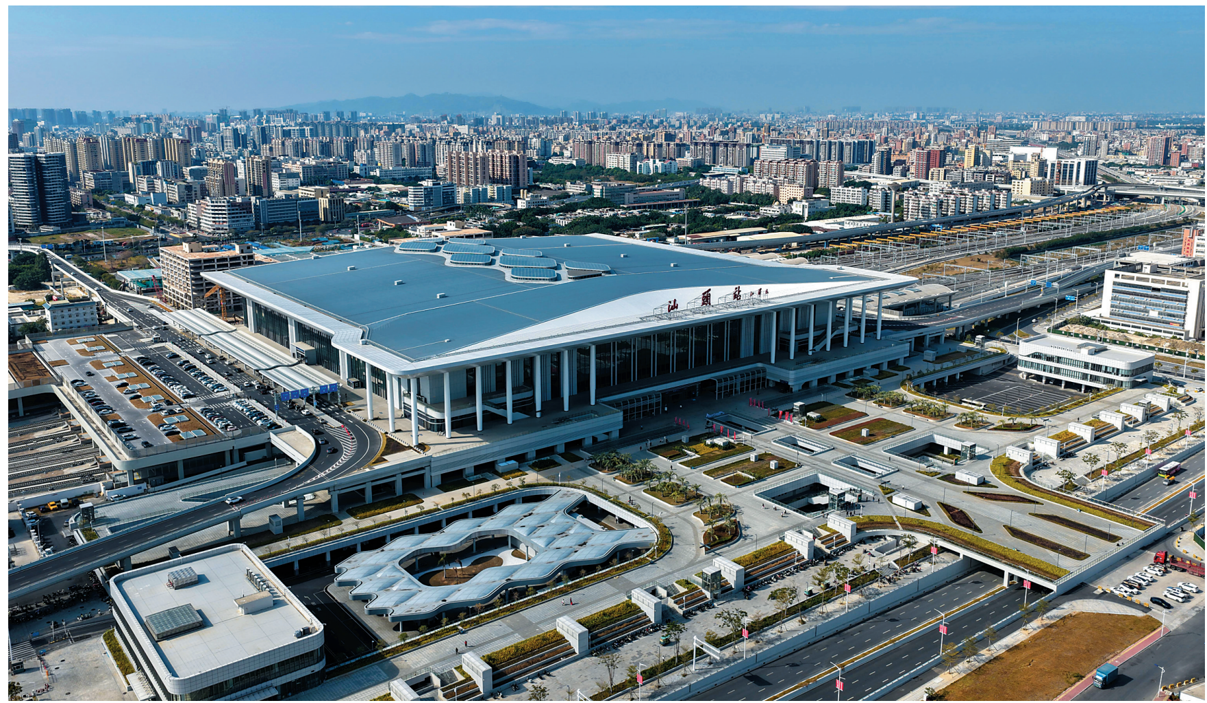
这是12月22日拍摄的高铁汕头站（无人机照片）。
