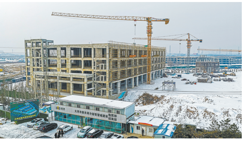
冬季施工暂歇，主体结构封顶的大同市新农商冷链智慧城巍然屹立。
