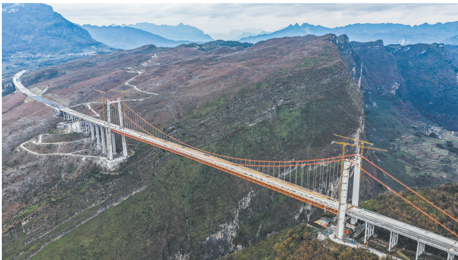
安盘高速天门特大桥主体工程完工。近日，贵州安（安顺）盘（盘州）高速天门特大桥主体工程顺利完工。大桥全长一千五百五十三米，桥面距峡谷水面约五百六十米。新华社记者 陶亮摄
