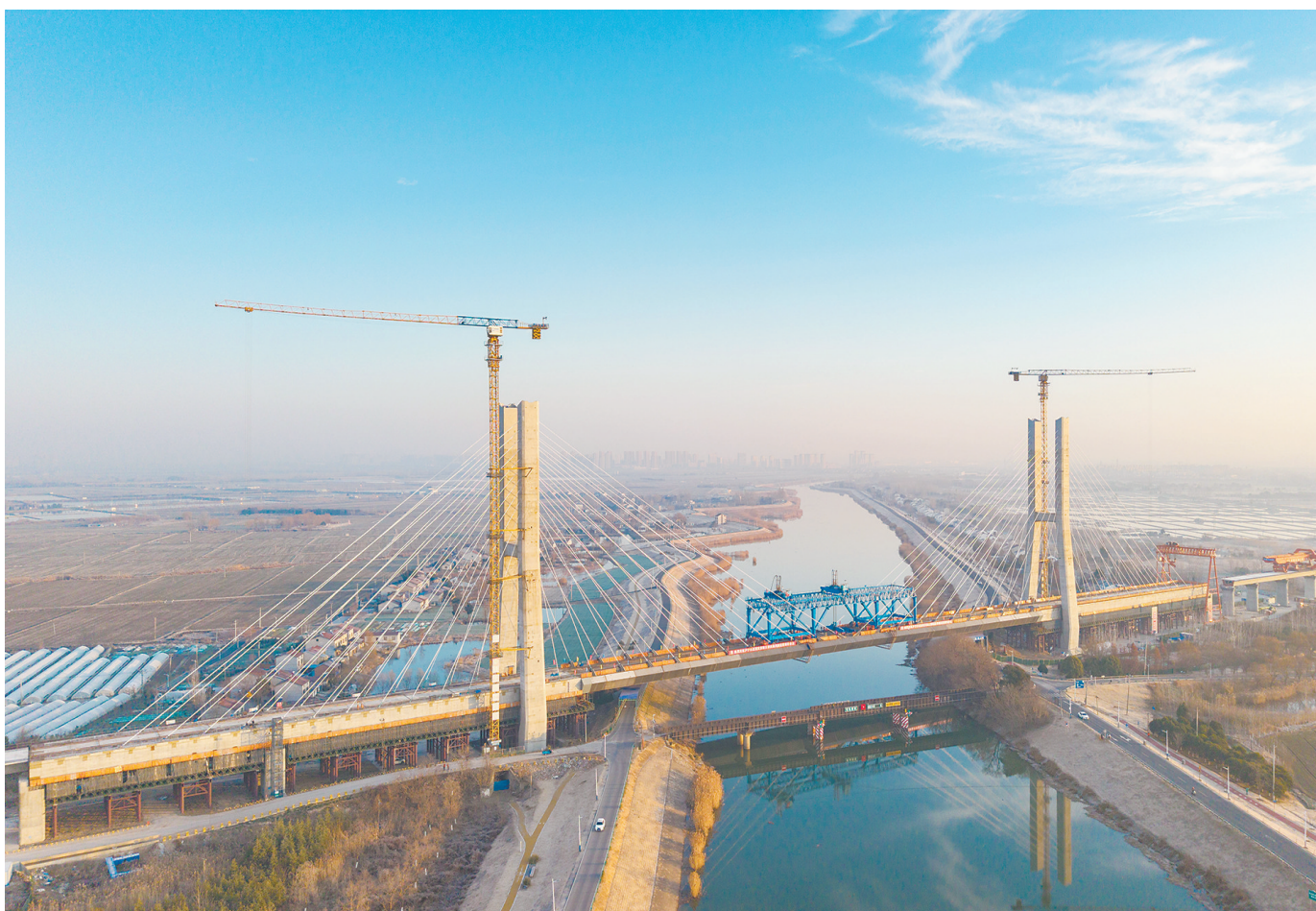
沪宁合高铁南京特大桥跨滁河斜拉桥顺利合龙
