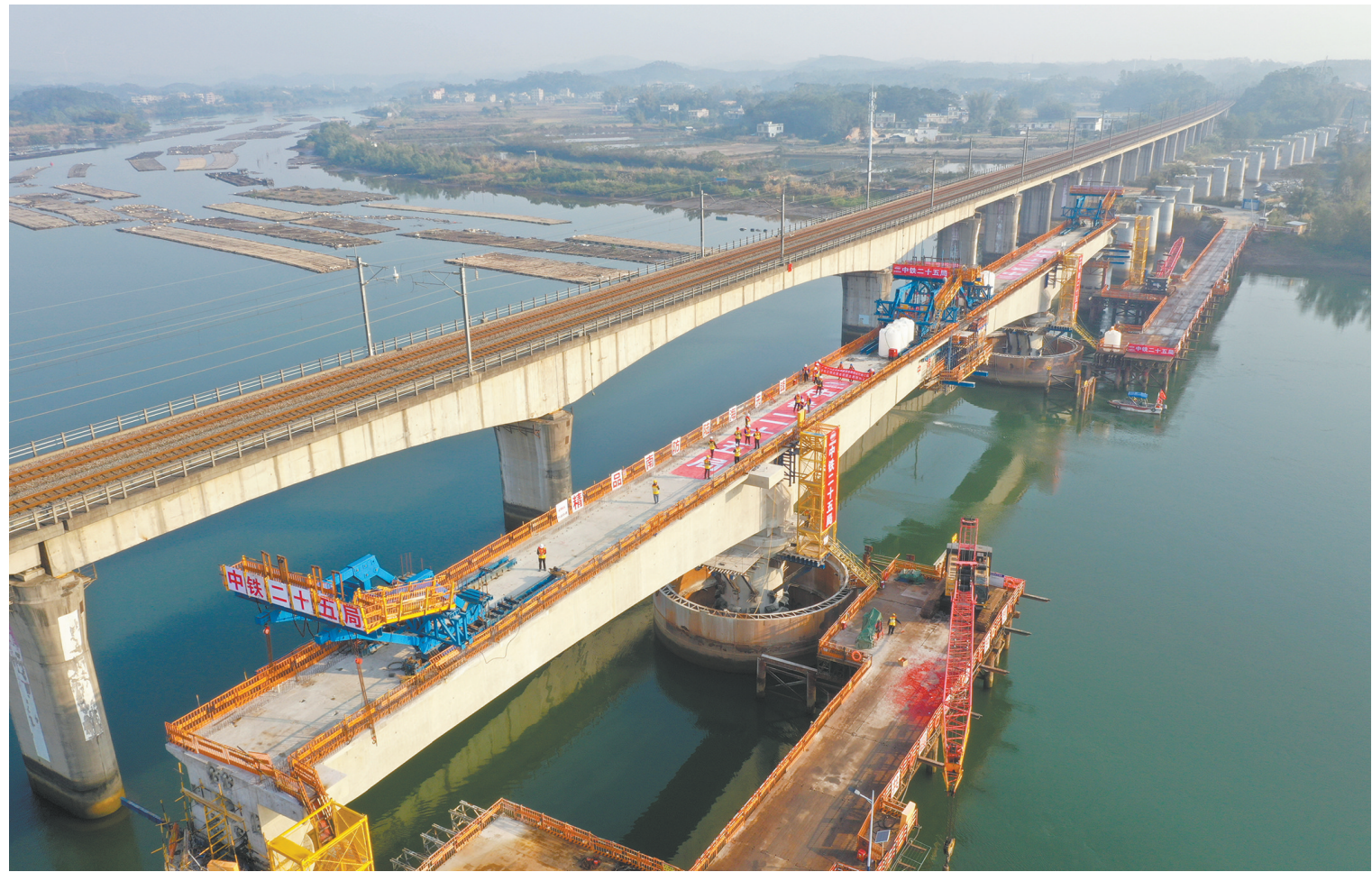
这是连续梁跨合龙后的南防铁路茅岭江特大桥（1月13日摄，无人机照片）。1月13日，南防铁路钦州至防城港段增建二线工程茅岭江特大桥连续梁跨合龙。南防铁路钦州至防城港段增建二线工程正线全长53.33公里，茅岭江特大桥是全线控制性工程，全长1087.94米。新华社记者 陆波岸摄
