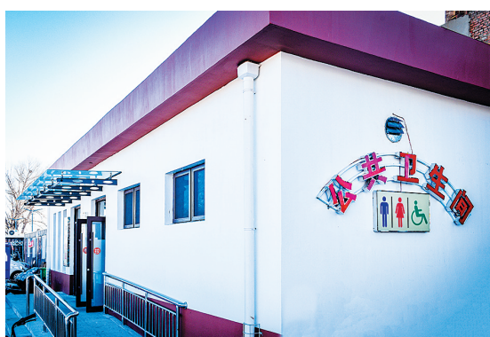
新修建的公共卫生间干净整洁，白墙红顶的外观与周边环境相得益彰。门口的无障碍坡道与扶手设计贴心，男女及无障碍标识清晰醒目，尽显人文关怀。
