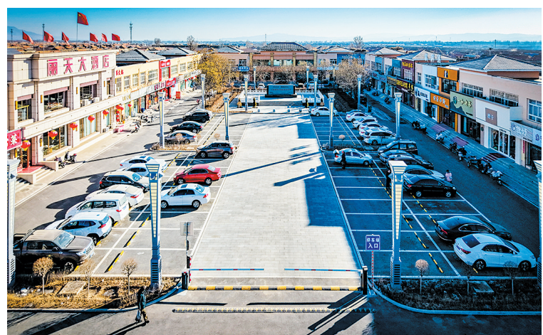
新修建的丽天广场停车场里车辆整齐停放，崭新的智能道闸和标识牌醒目规范。
