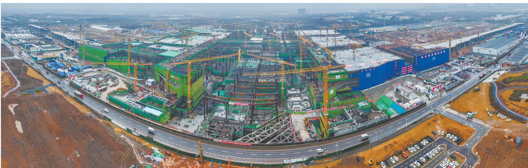
南京北站全面转入地上结构施工阶段
