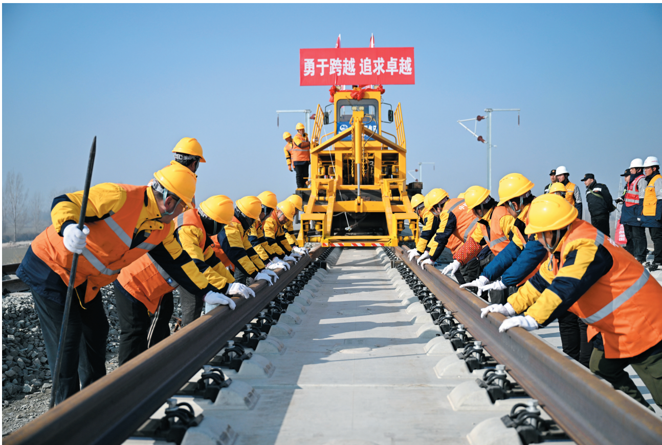
2月1日，中铁三局集团施工人员在雄忻高铁首对钢轨铺设现场作业。2月1日上午，在河北省保定市顺平县的雄忻高铁建设现场，中铁三局集团施工人员进行首对500米长钢轨平稳、精准地铺设在无缝道床上，标志着雄忻高铁正式进入铺轨施工阶段。
