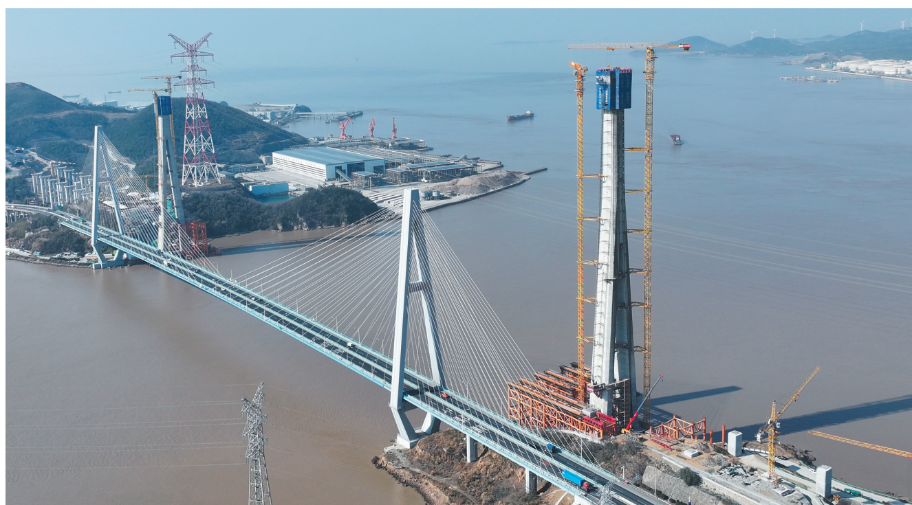
甬舟铁路桃夭门公铁两用大桥6号主塔顺利封顶
