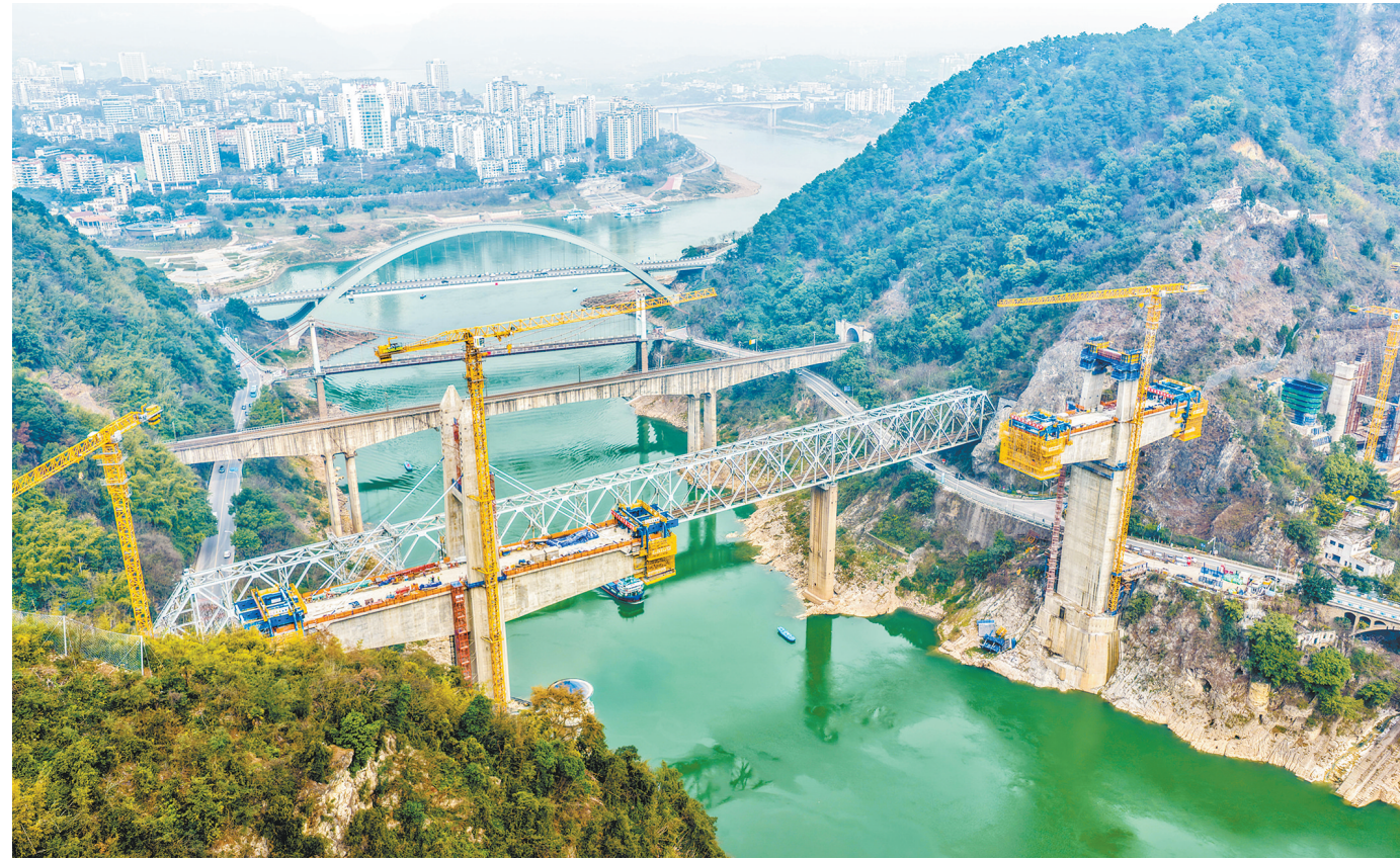
这是二月十日拍摄的西渝高铁嘉陵江特大桥建设现场（无人机照片）。 二月十日，由中铁十一局承建的西渝高铁嘉陵江特大桥首跨顺利合拢。 西渝高铁是我国“八纵八横”高铁网北京至昆明通道的重要组成部分。 新华社记者 唐奕摄
