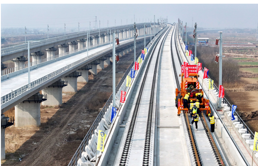
3月10日,在(济)南(滨)州)高铁山东滨州站,中铁四局的工作人员在进行铺轨作业(无人机照片)。
