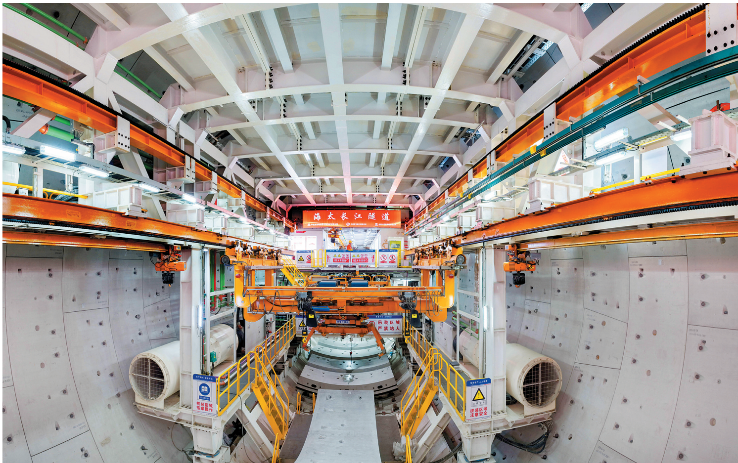
3月22日拍摄的海太长江隧道“江海号”盾构机掘进施工现场（无人照照片）。
