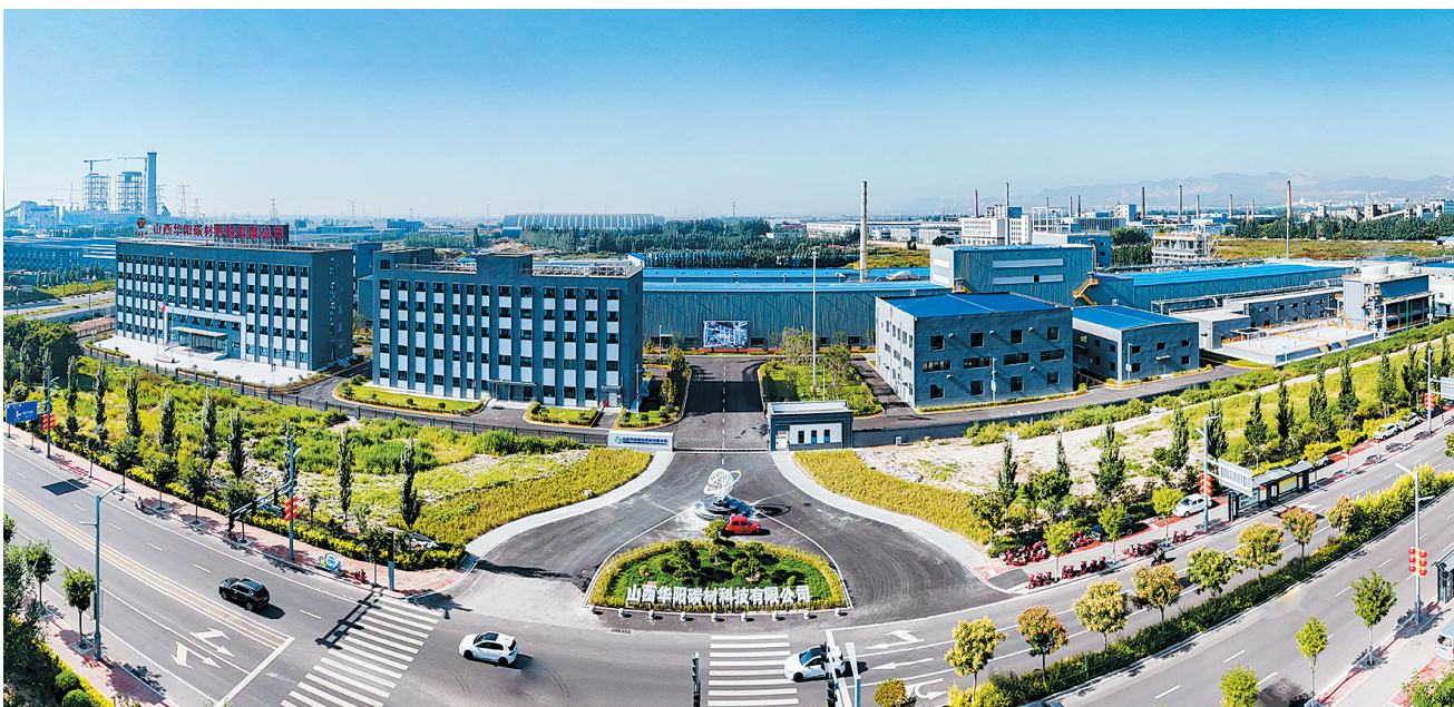
华阳碳纤维千吨级高性能碳纤维示范项目。
