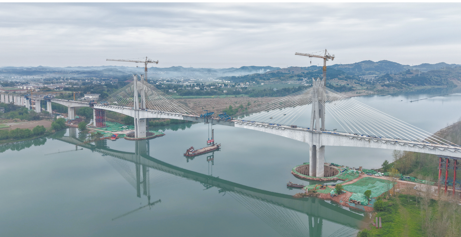
3月25日，在成达万高铁嘉陵江特大桥施工现场，最后一段钢箱梁吊装施工中（无人机照片）。3月25日，成都至达州至万州高速铁路（简称成达万高铁）全线控制性工程嘉陵江特大桥顺利合龙，为成达万高铁按期通车奠定了坚实基础。嘉陵江特大桥位于南充市顺庆区与高坪区交界处，是成达万高铁全线“3隧4桥”重难点控制性工程之一。新华社记者 江宏景摄
