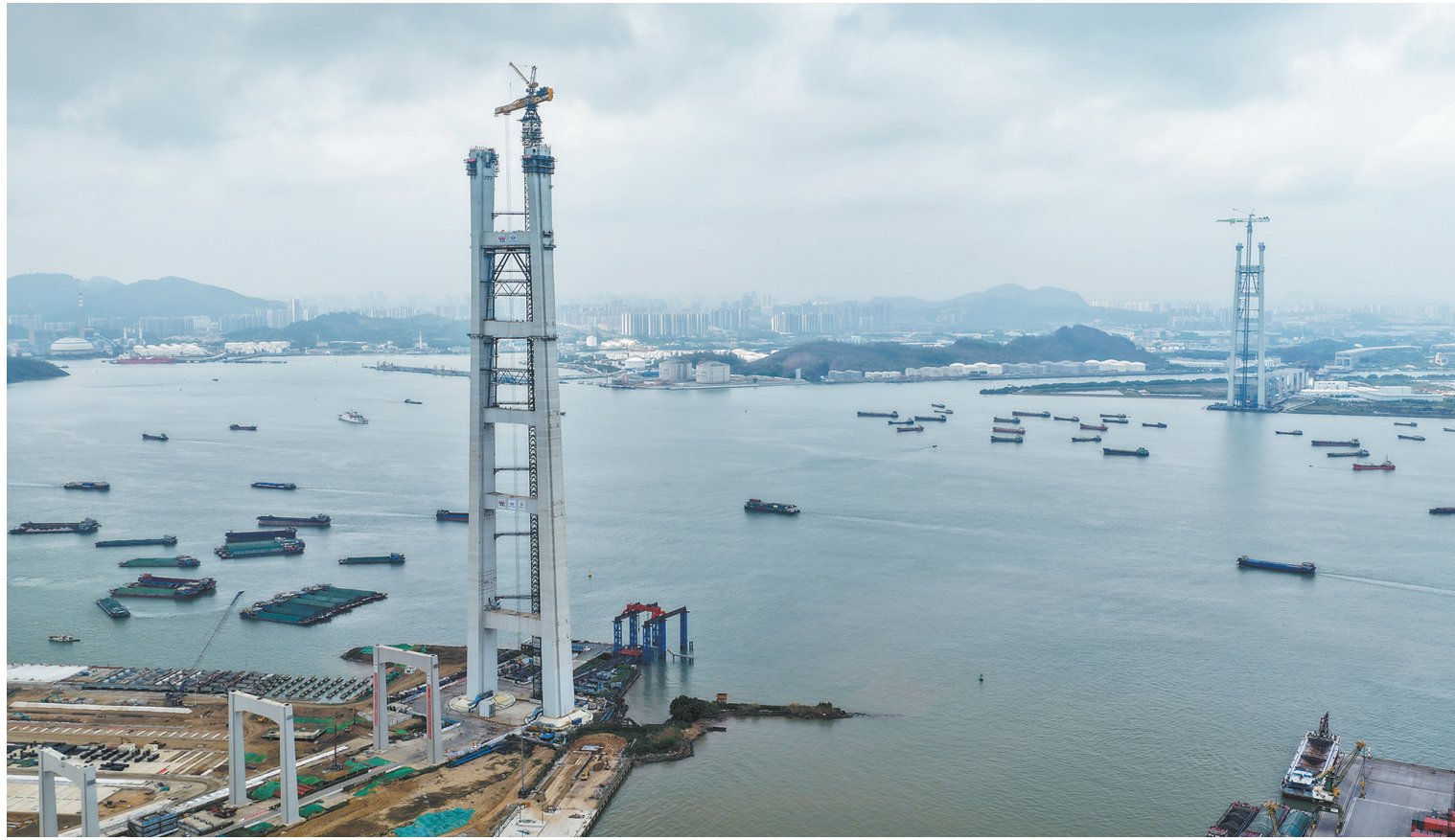
这是3月26日拍摄的狮子洋大桥东、西主塔(无人机照片)。
