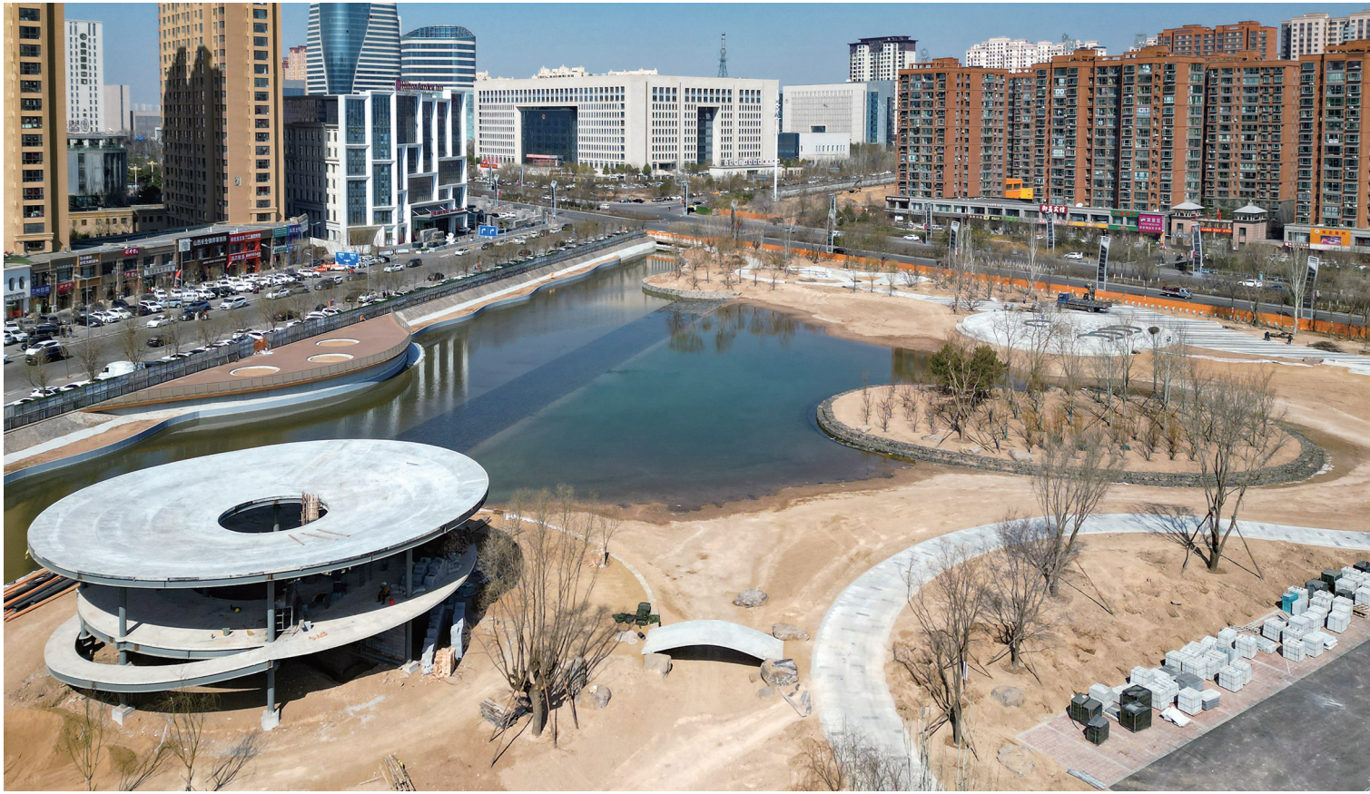
连日来，御河灌区西干渠水生态综合治理工程全线复工，提速攻坚。这条纵贯御河南北的生态廊道雏形初现，两岸地形修整工作已收尾，工人们正紧锣密鼓地推进两岸绿化、人行道路及栏杆安装等附属工程，同步加快剩余3座钢坝闸及“大跳水”景观建设，确保按期呈现“水脉贯通、绿道相连”的生态廊道，为城市再添一条集灌溉、防洪、生态、休闲于一体的民生绿脉。本报记者 戎禹仁摄
