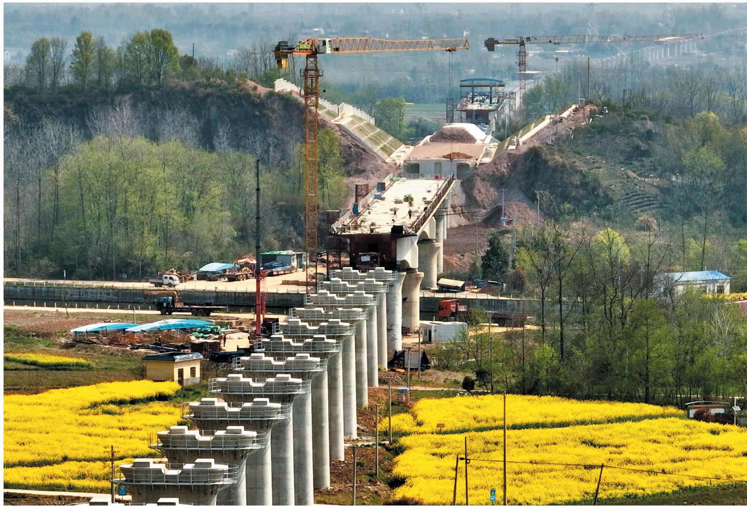
三月二十九日，中铁十一局一工人在合武高铁安徽段灌集白塔墩特大桥连续梁施工现场作业（无人机照片）。春日，中铁十一局合武高铁安徽段灌集白塔墩特大桥施工现场一派繁忙，施工人员利用春季有利天气，高标准高质量推进项目建设。合武至武汉高速铁路是我国“八纵八横”高铁网沿江通道的重要组成部分，设计时速三百五十公里。线路建成后，将在合肥至武汉间形成新的高铁大通道，进一步优化长江经济带铁路网布局。
