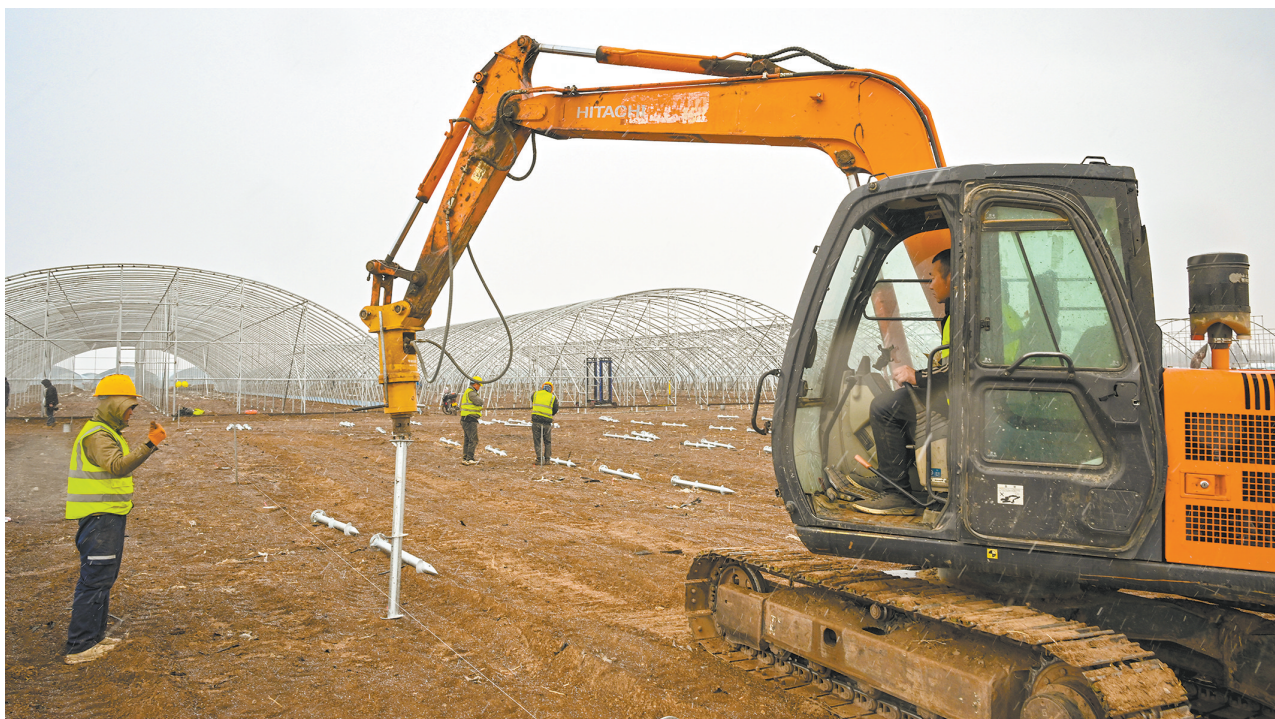
3月31日，云冈区杜庄乡升辉农业设施蔬菜种植基地正加快建设，工人抢抓工期搭建钢架冷棚。该项目总投资7700万元，规划2665亩，分两期打造集智能种植、育苗于一体的现代设施农业集群。一期1380亩冷棚已于2025年投产，二期正在推进建设中。基地配套水肥一体与智能数控系统，并建设全市首个无人化智能化育苗中心，年育苗超100万盘。产品直供一线城市高端市场，以“以销定产”带动周边农户增收，为乡村振兴注入强劲动能。 本报记者 张燕伟摄
