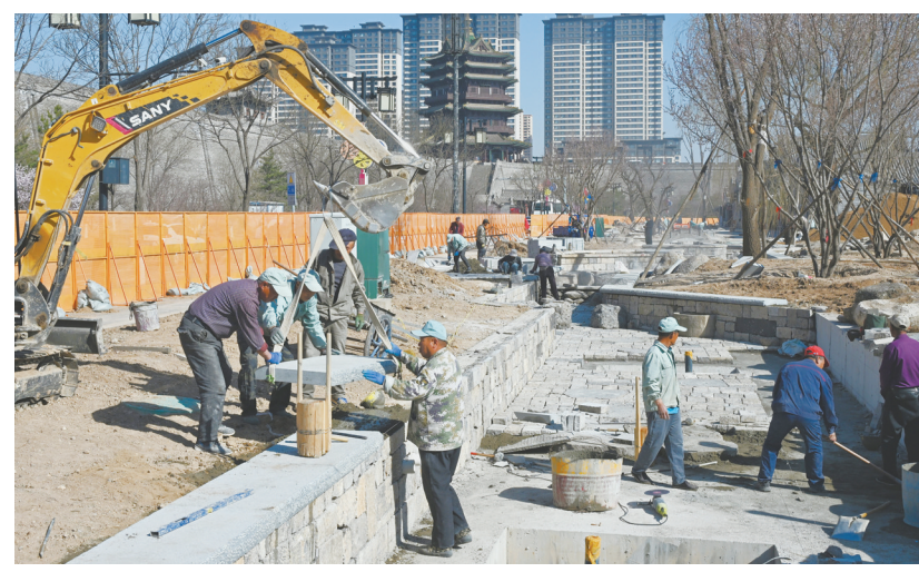
春和景明,复工提速。4月2日,大同古城生态水系工程施工现场一派繁忙,工人们有序推进石材铺装、景观营造等作业,全力保障项目建设提速高效。
