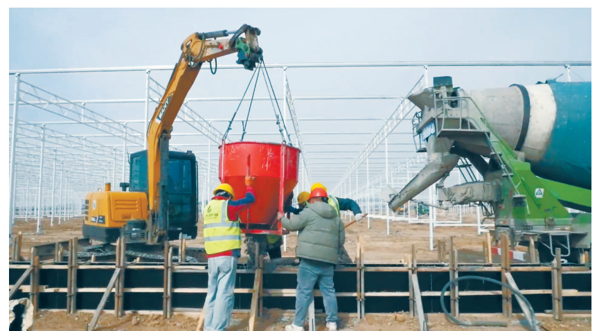
仲春时节，在云州区慧农现代农业科技产业园(二期)建设现场，一派热火朝天的繁忙景象。苑捷摄
