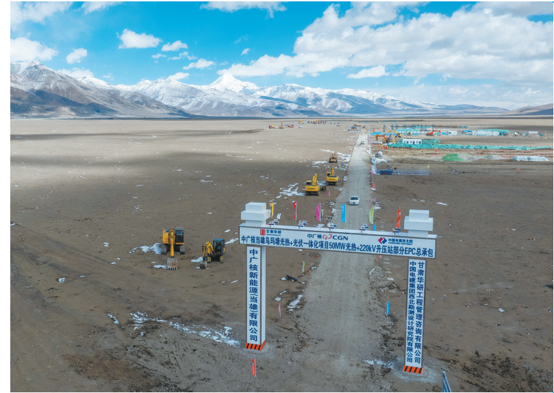
这是中广核西藏当雄乌玛塘50兆瓦光热电站破土动工现场（4月6日报，无人机照片）。4月6日上午，中广核西藏当雄乌玛塘“光热+光伏”一体化项目中的50兆瓦光热电站在拉萨市当雄县乌玛塘乡正式开工建设。据中广核光热技术型号首席专家尹航介绍，该项目场址海拔4550米，是目前全球海拔最高的槽式光热电站。 新华社记者 丁增尼达摄
