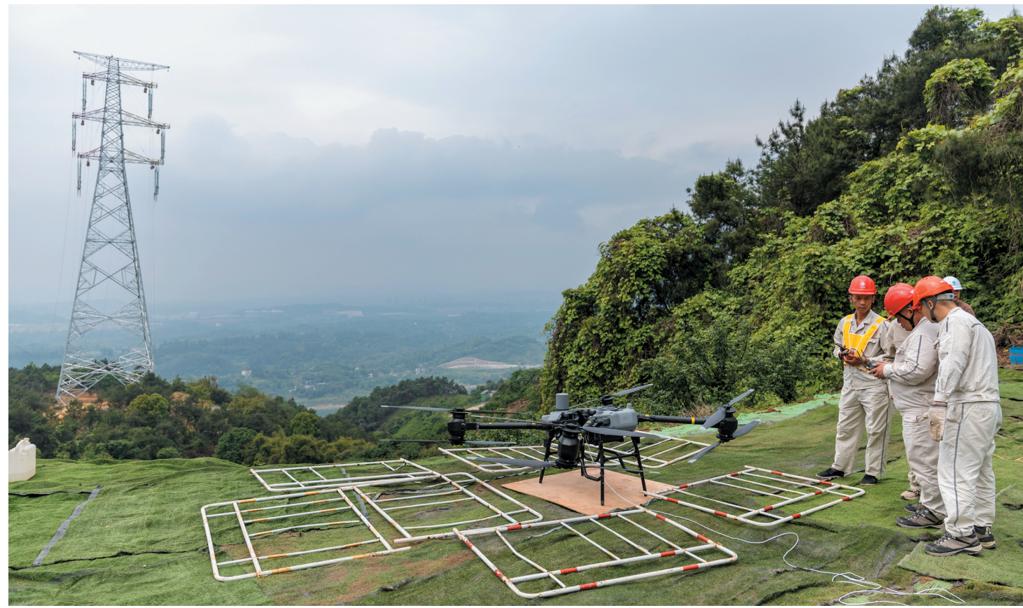
重庆：无人机新技术助力电力跨长江放线施工
