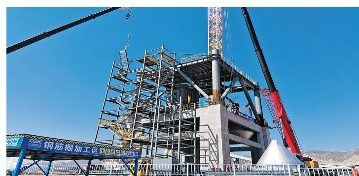
煤矸石综合利用项目现场，悬浮预热器钢结构框架已拔地而起。
