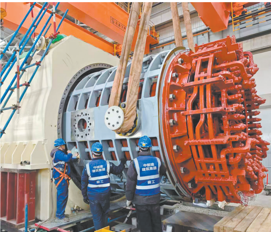
图为同热三期2×100万千瓦煤电工程2号发电机内定子穿装现场。 贾晓龙摄
