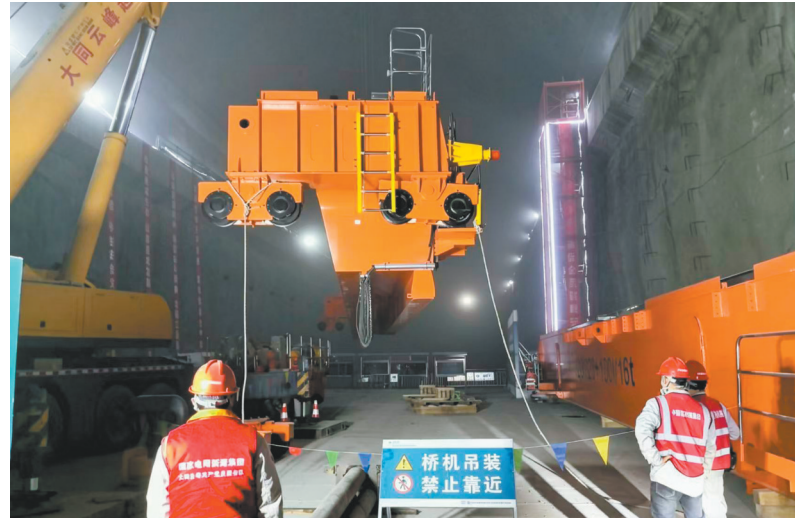
图为桥式起重机正在实施吊装作业。张彩峰摄
