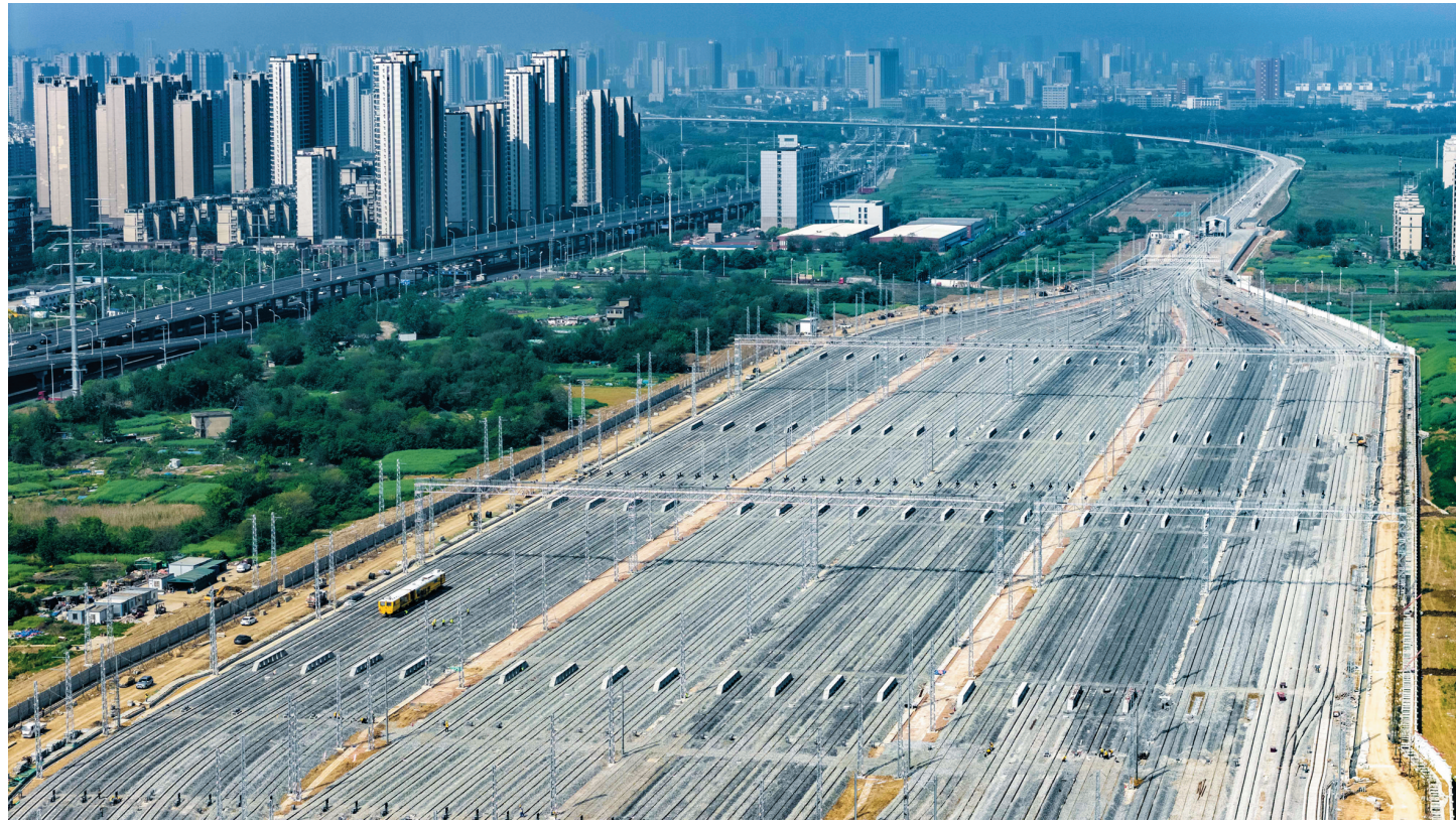
合肥动车运用所建设 进入全面冲刺阶段
