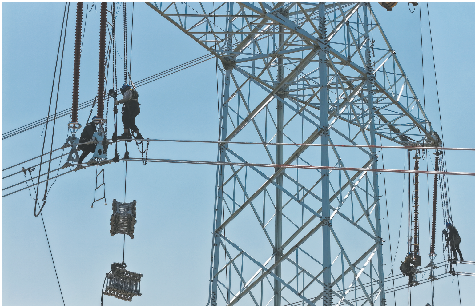
平城—大同500kV线路工程建设提速,目前铁塔组立已全部完成,工程重心全面转向线路架设阶段,架线进度已达整体工程量的59.86%。据悉,该工程属于大同1000千伏送出工程,新建铁塔163基,线路65.26公里,为晋北绿电外送关键通道。工程建成后,将完善大同区域500千伏骨干网架,提升晋北新能源基地汇集送出能力,保障京津冀供电。 本报记者 张占兵 摄
