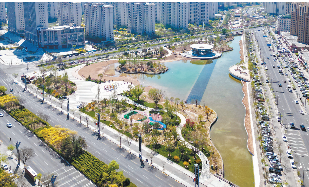
近日，御河灌区西干渠水生态综合治理工程核心区景观区恒安街至恒源路渠段（水之语公园）进入施工收尾阶段。4月30日，记者在现场看到，施工围挡已全部拆除，园路铺装、观景平台、亲水平台、景观配套建筑等主体工程均已完工，园林工人正抢抓时节栽植花卉、铺设草皮，同步开展补水作业。
