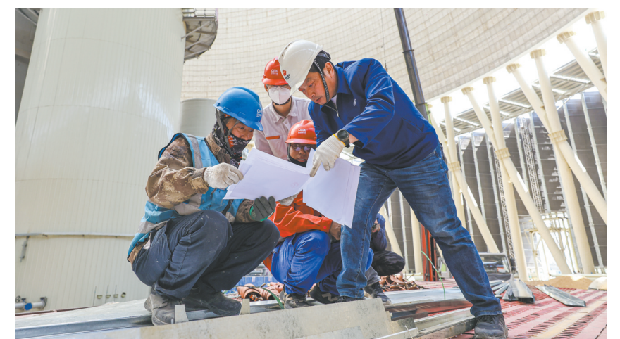
“五一”假期，国电电力湖东电厂的建设现场一片繁忙。张彩峰摄
