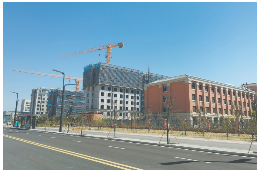
图为正在建设中的大同数据科技职业学院二期工程。
