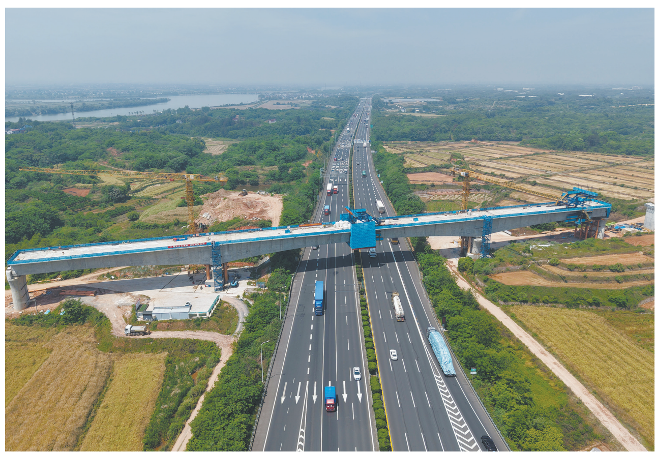
这是5月7日拍摄的衢甬铁路衢江特大桥跨沪昆高速公路连续梁(无人机照片)。
