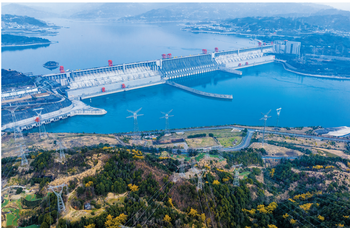
2025年2月7日在湖北宜昌拍摄的三峡大坝和外送输电线路(无人机照片)。新华社发(郑家裕摄)
