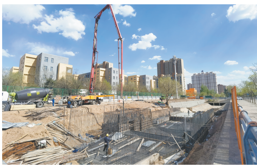
在御河灌区西干渠水生态环境综合治理工程项目现场，建设者们以精细化作业确保工程质量。孙晓娟摄
