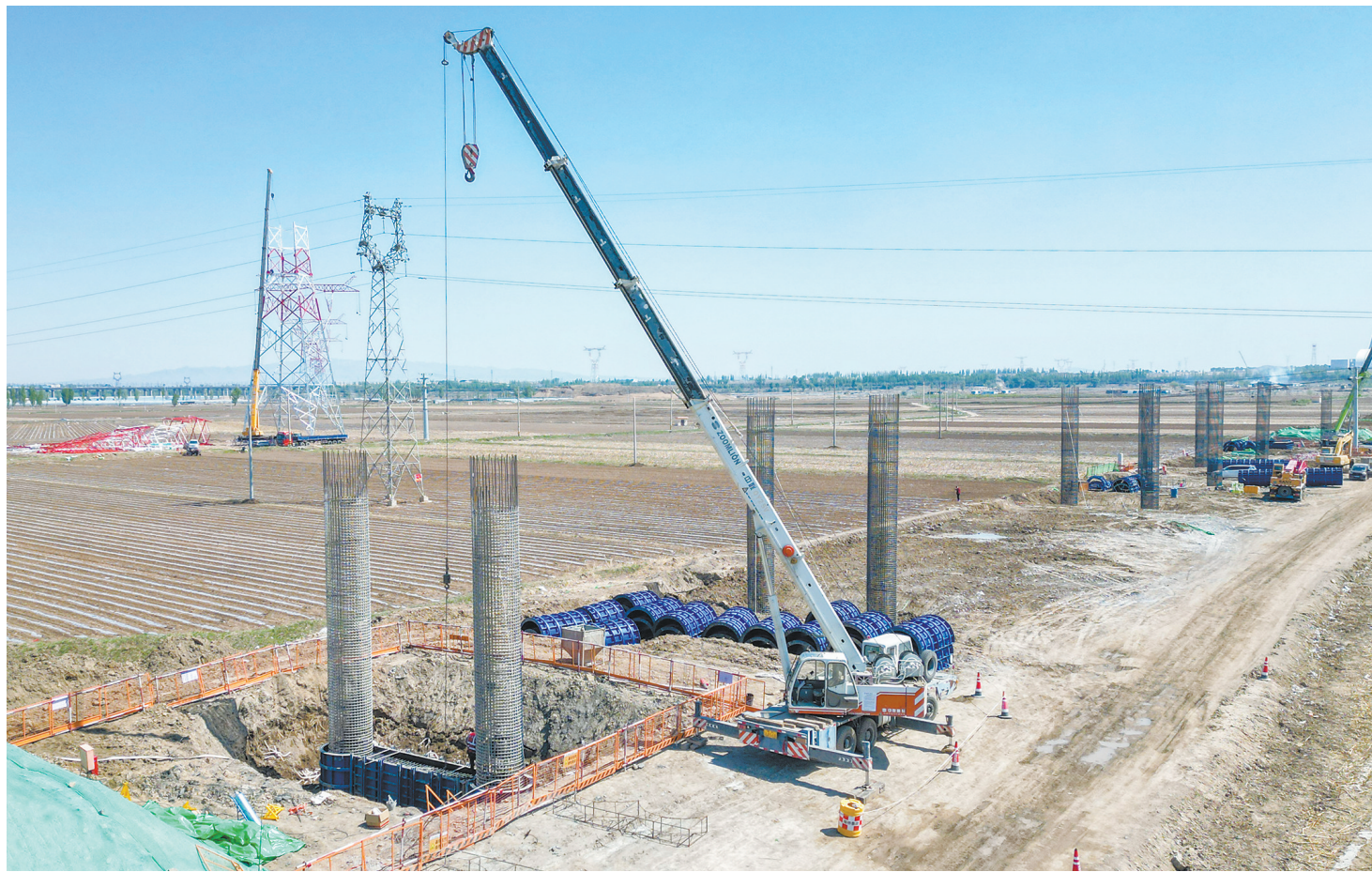
连日来，山西省重点工程——大同绕城高速公路陈庄至肥村段项目施工现场，机械轰鸣、车辆穿梭、人员奋战，一派热火朝天的繁忙景象。项目建设正高效推进、稳步实施。该项目总投资24.28亿元，路线全长22.587公里，采用双向四车道高速公路标准建设，是我市完善高速公路网、物通区域循环的重要工程。项目建成后，将有效联通天黎高速与二广高速，构建起平城区、云州区、云冈区快速交通网络，进一步优化城市交通布局，拉大城市发展框架，为我市拓展城市空间、推动经济社会高质量发展提供坚实交通保障。本报记者 戎禹仁摄
