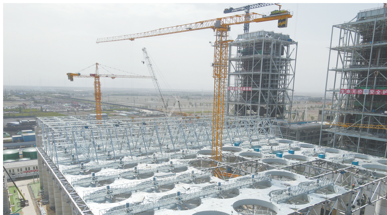
图为同热三期空冷柱施工现场。
