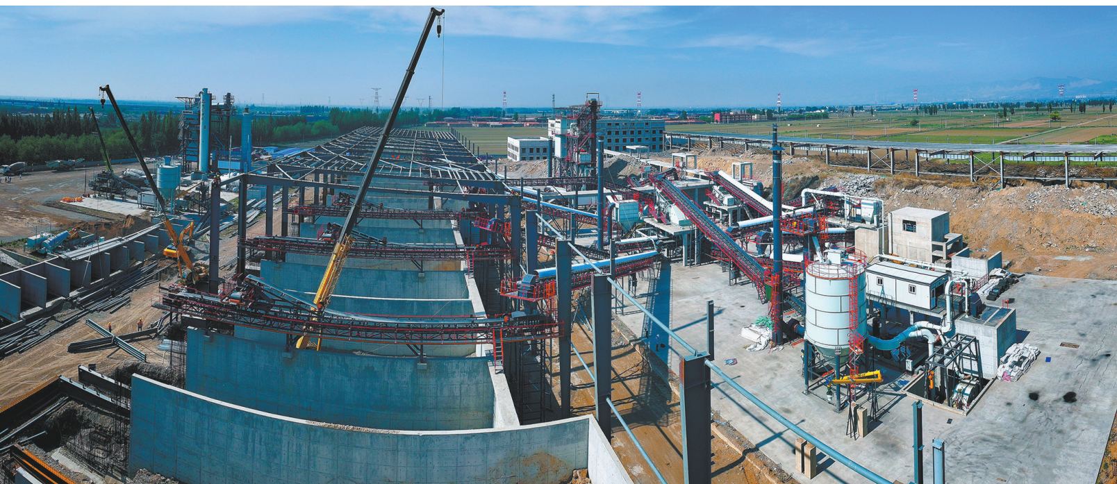
图为富凯鸿新型建材科技产业园施工现场。本报记者 于宏摄
