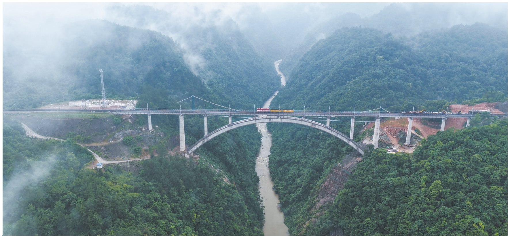
瓮马铁路南北延伸线瓮安至天文段长轨贯通
