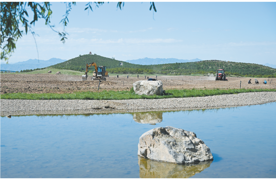
作为大同火山群国家地质公园新晋晋点，黄家洼草坪深受市民游客青睐。为持续优化游玩体验，园区正式启动草坪养护与扩建施工。项目在原有绿地基础上扩容拓展，完工后绿地空间将显著提升，并打造出高品质休闲场地，擦亮火山地质公园文旅名片。
