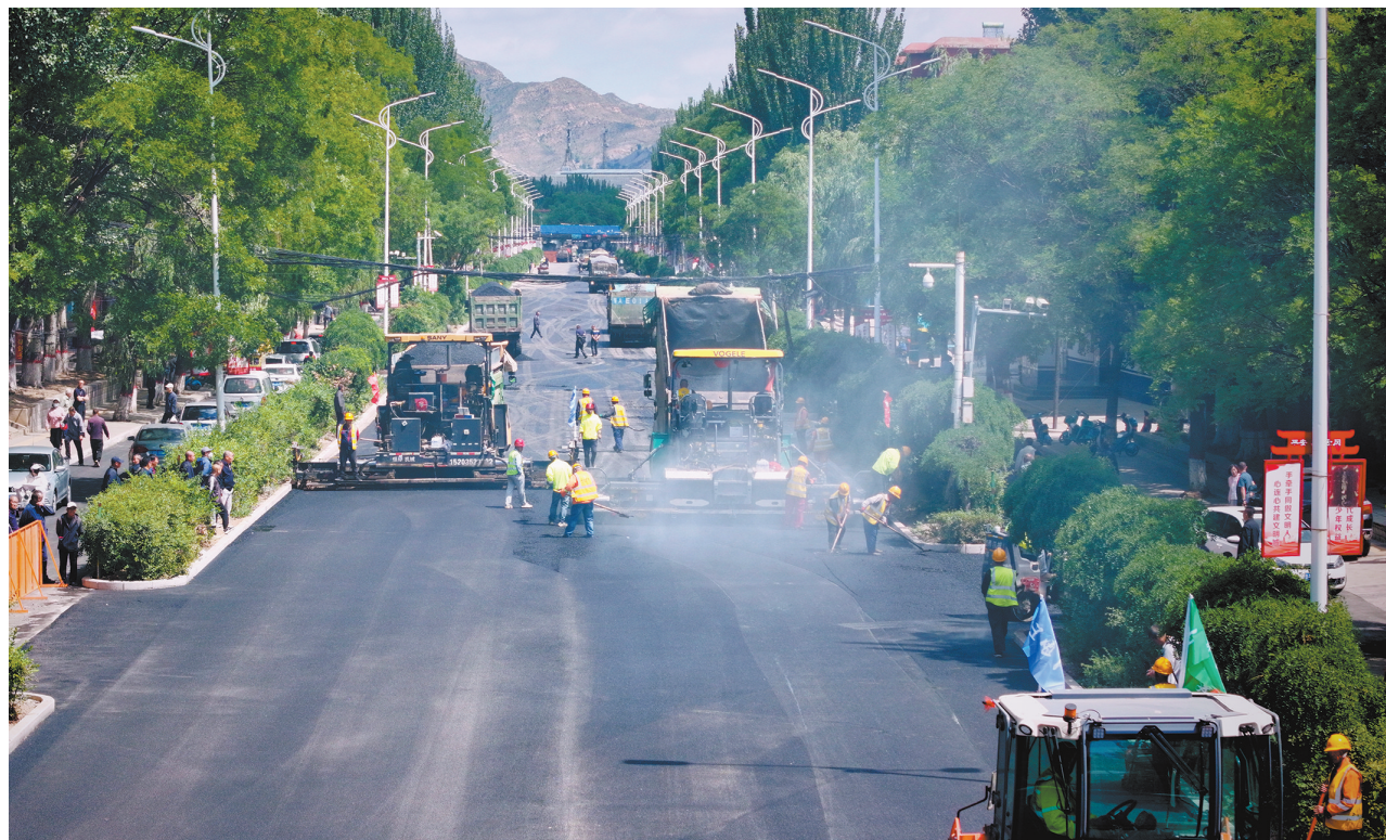
6月10日，随着最后一段沥青路面压实成型，云冈区平泉街改造工程主线摊铺任务顺利完成，当日即具备通车条件。据了解，该项目属我市中心城区老旧排水管网改造工程一标段，涵盖泉辉街、校北街、林荫路、新胜东街等13条道路，改造雨污水管道总长24.98公里，于2025年9月27日开工。目前，新胜东街主线已全面通车，为配合高考保障，校北街已于6月4日提前通车。图为在云冈区平泉街改造工程主线摊铺现场，机械设备正有条不紊地推进路面摊铺、压实等工序。
