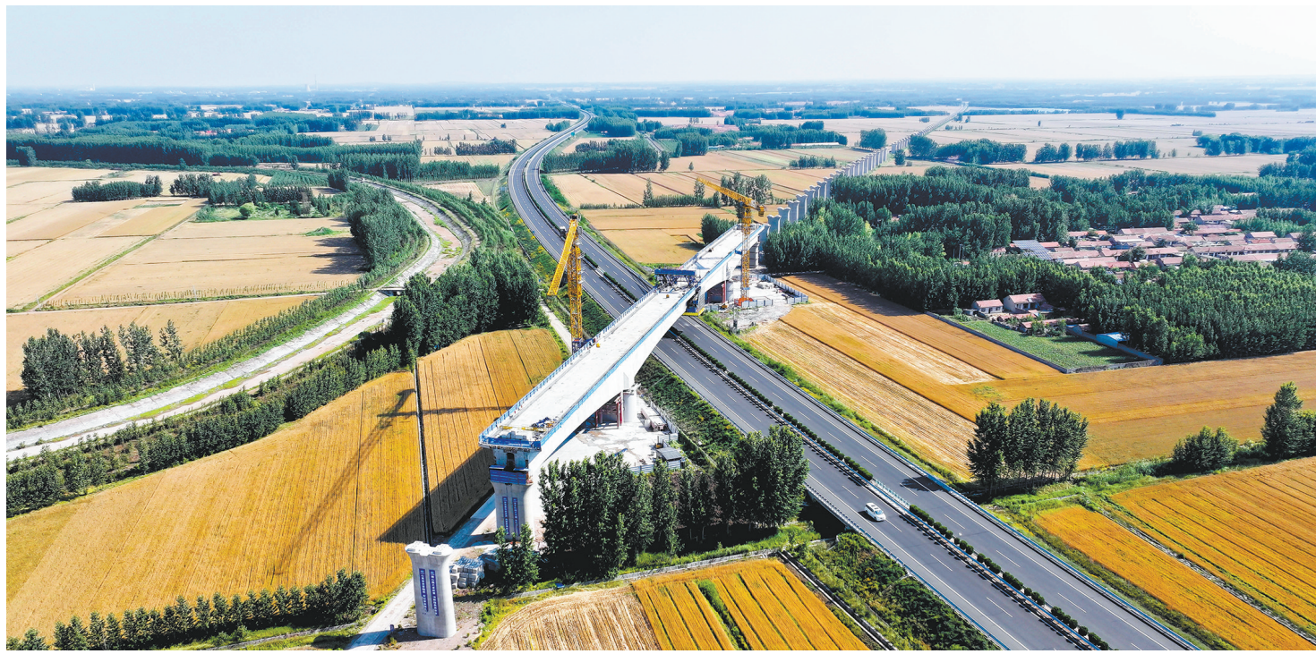
这是六月十一日拍摄的津浦高铁跨海日高速连续梁顺利合龙的画面（无人机照片）。六月十一日，由雄安高速铁路有限公司建设、中铁十一局承建的津（场）宿（迁）高铁诸城河特大桥跨海（场）日（照）高速连续梁顺利合龙，为后续各项施工奠定坚实基础。新华社记者 郭绪雷摄
