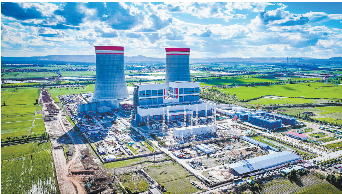
图为国电电力湖东电厂2×100万千瓦火电项目建设现场。本报记者 韩莹摄
