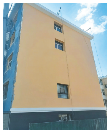
对云冈区二粮库小区楼体开渠保温层修复工作。
