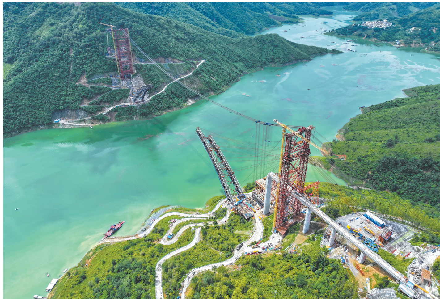
7月3日,红水河铁路大桥拱肋正在进行吊装(无人机照片)。
